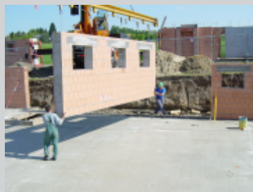
Anheben der Mauertafel von den Transportpaletten
