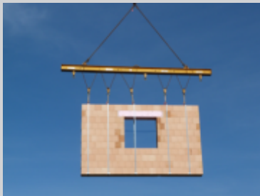
Anheben der Mauertafel von den Transportpaletten
